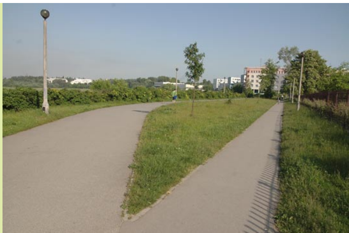
Aleja spacerowa wzdłuż krawędzi Łąk od strony północnej (fot. S. Wójcik)
