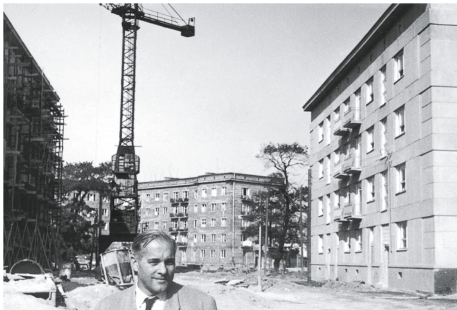
Tadeusz Ptaszynski na budowie os. Hutniczego w Nowej Hucie
